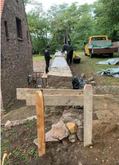
Stützmauern entfernt, danach gereinigt und mit neuem Fugenmaterial ausgefüllt. Ebenfalls wurde eine neue Abdeckung entlang der oberen Mauer verlegt und die Treppentufen zur vorderen Rasenfläche gerichtet. Um den Fußbereich der Stützmauern zu stabilisieren, wurde davor eine Pflasterzeile aus Granitsteinen in Beton verlegt.
